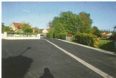
La partie terminale du chemin du Mont encore provisoire, a été achevée et complétée par quelques aménagements connexes concernant notamment le pluvial. La couche de roulement en enrobé ainsi réalisée représente une surface globale de 1 950 m<sup>2</sup>. Le coût des travaux subventionnés à 25 % est de 41 841 € HT.
